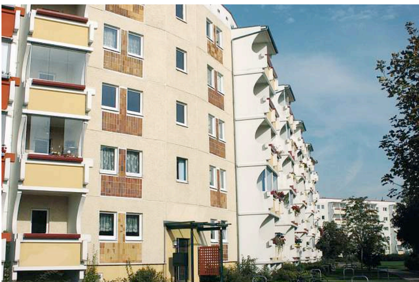
Gut sichtbar die Elemente, oder eben Platten, am Beispiel eines Plattenbaus in Rostock. (Foto Agentur Nordlicht)
