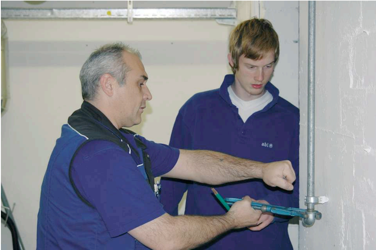
abl-Handwerker Peter Thürig zeigt Rafael Rohrer, wie er eine Wasserleitung ausrichten kann.
