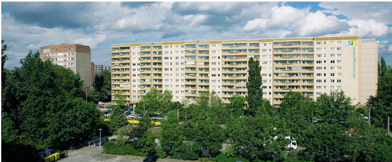
Plattenbausiedlung der Wohnungsbaugenossenschaft DPF in Berlin, ebenfalls Mitglied im Gästewohnungstauschring. (Foto DPF)
