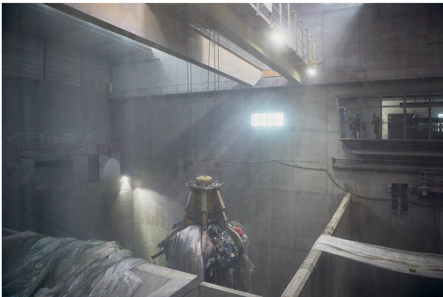
Oben: das imposante KVA-Gebäude. Über einen Steg gelangen Mitarbeiter und Besucherinnen zum Haupteingang. Unten: Dieser Greifer kann bis zu sechs Tonnen Abfall aufs Mal krallen, um ihn korrekt zu verteilen und für den Verbrennungssofen vorzubereiten.
