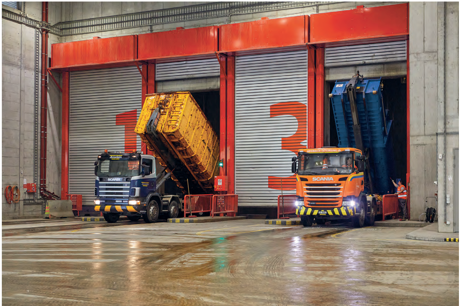
Die Anlieferhalle der Kehrichtverbrennungsanlage Renergia in Perlen. Die Chauffeure dieser beiden Lastwagen entleeren gerade ihre mit Abfall gefüllten Mulden in den sogenannten Abkippbunker.
