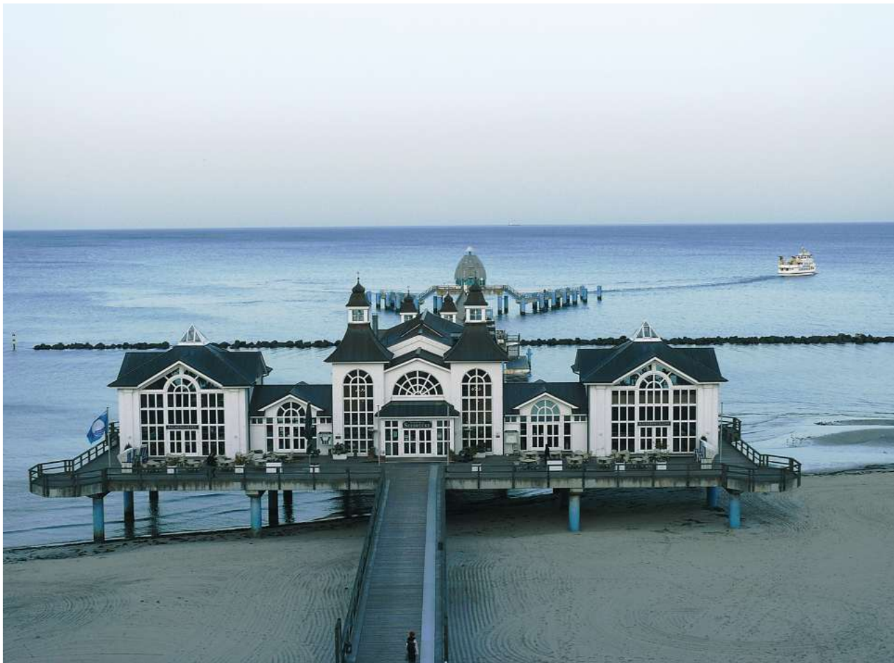
Selliner Seebrücke mit Tauchglocke.
