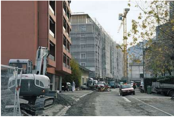
Einbau Dachwohnungen und Fassadensanierung Spannortstrasse.
