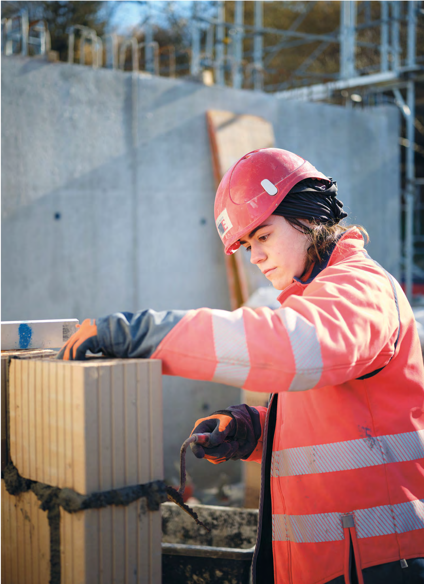
Sorgfalt, Geduld und Genauigkeit sind beim Mauerbau gefragt – «jufle» bringt nichts.
