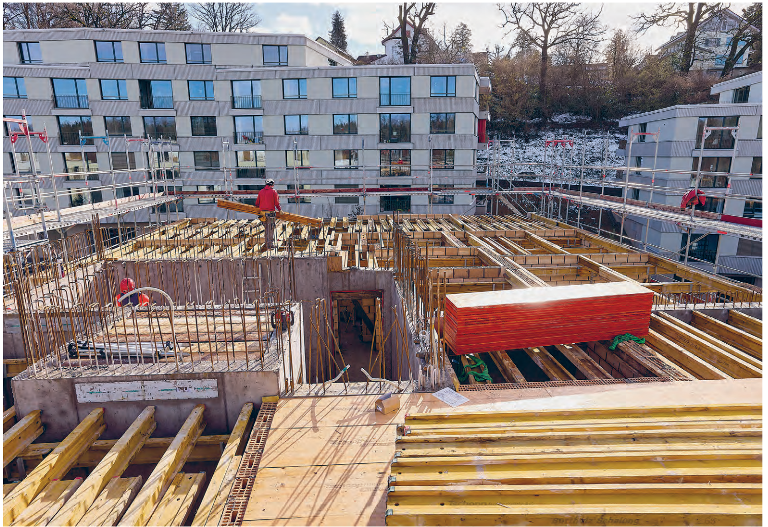
Die Decke des dritten Obergeschosses der künftigen Maihofhalde 11 wird vorbereitet.
