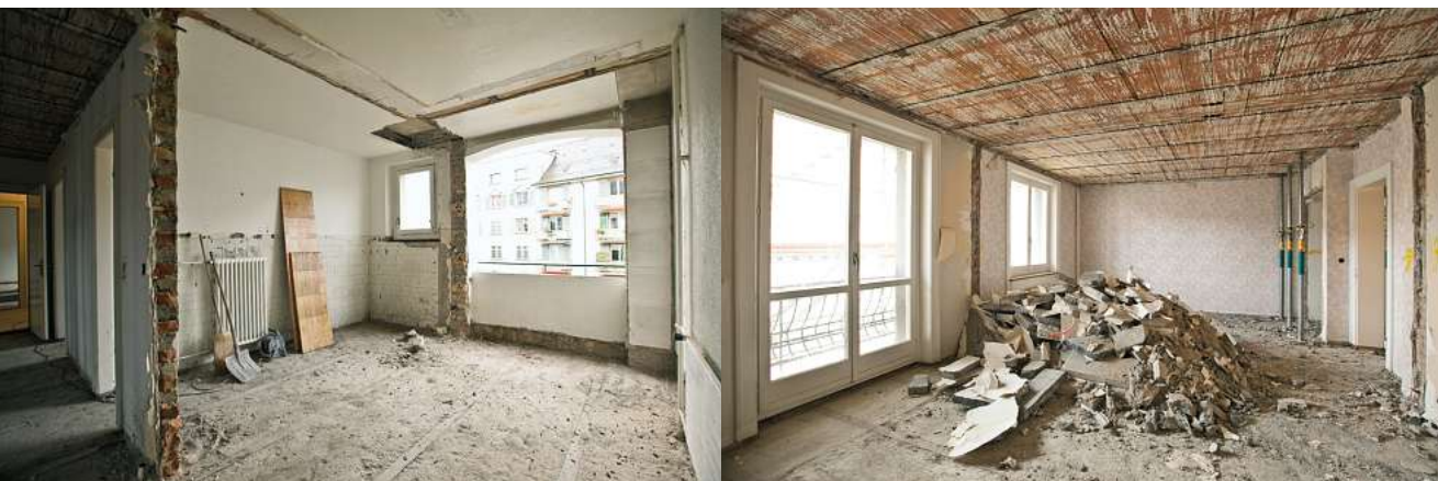
Neue, grosse Wohnräume sind bereits erkennbar.
