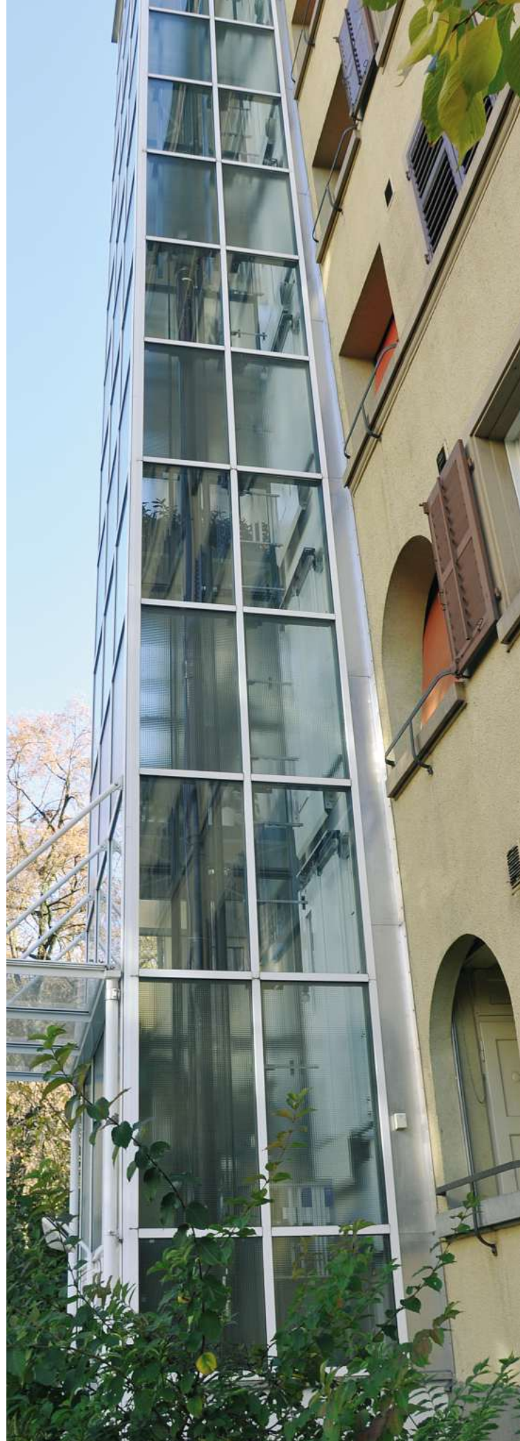
Schräglage – Die Blechabdeckung verjüngt sich um 25 cm vom Erdgeschoss bis ins 5. Obergeschoss.
