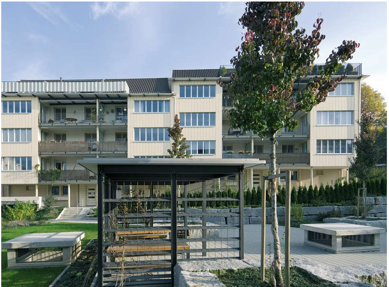
Auf dem Dach der neuen Autoeinstellhalle am Mönchweg.
