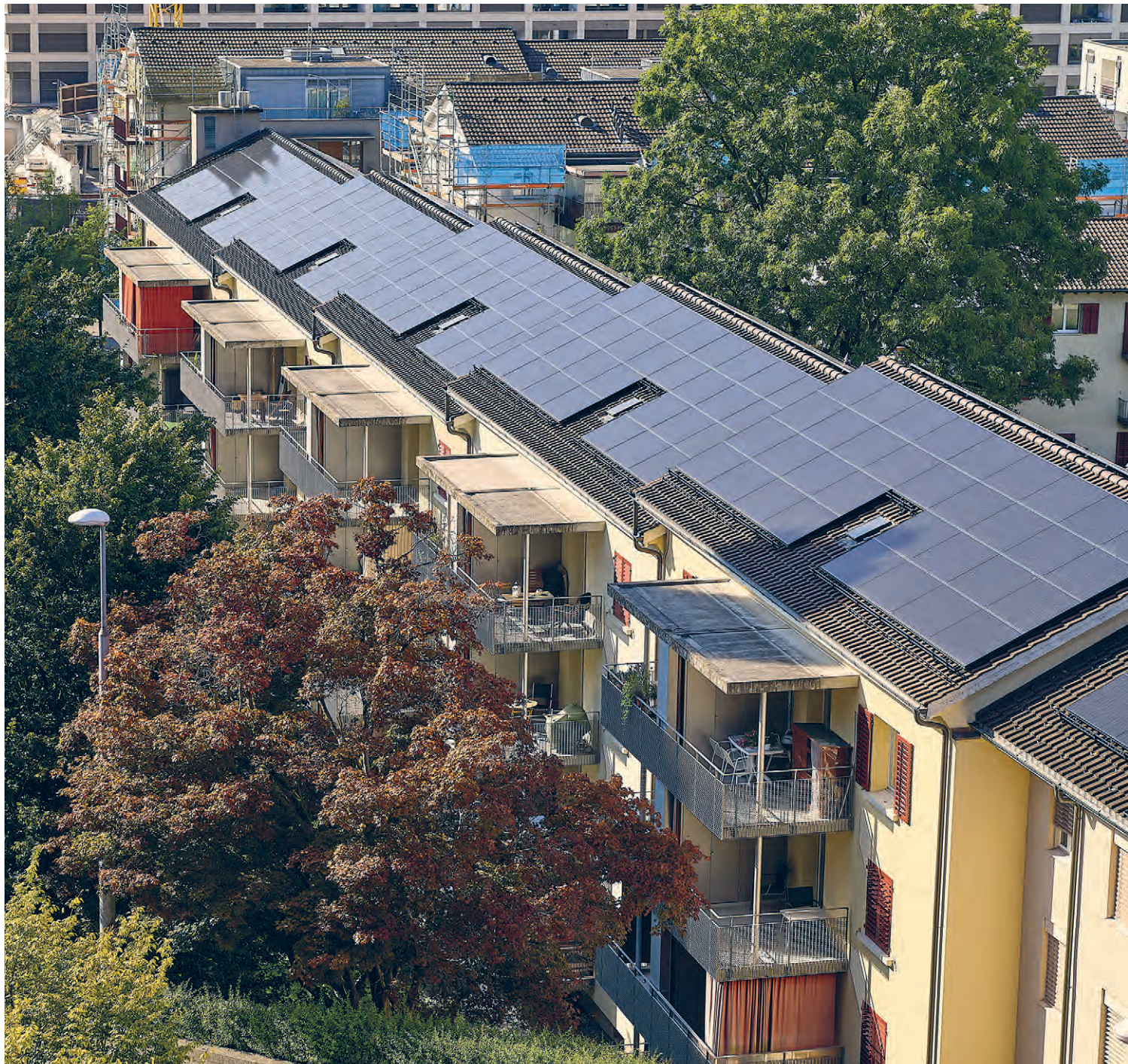
Mit dem Bau von zusätzlichen Photovoltaikanlagen im Weinbergli wurde die Eigenstromproduktion nahezu verdoppelt.
