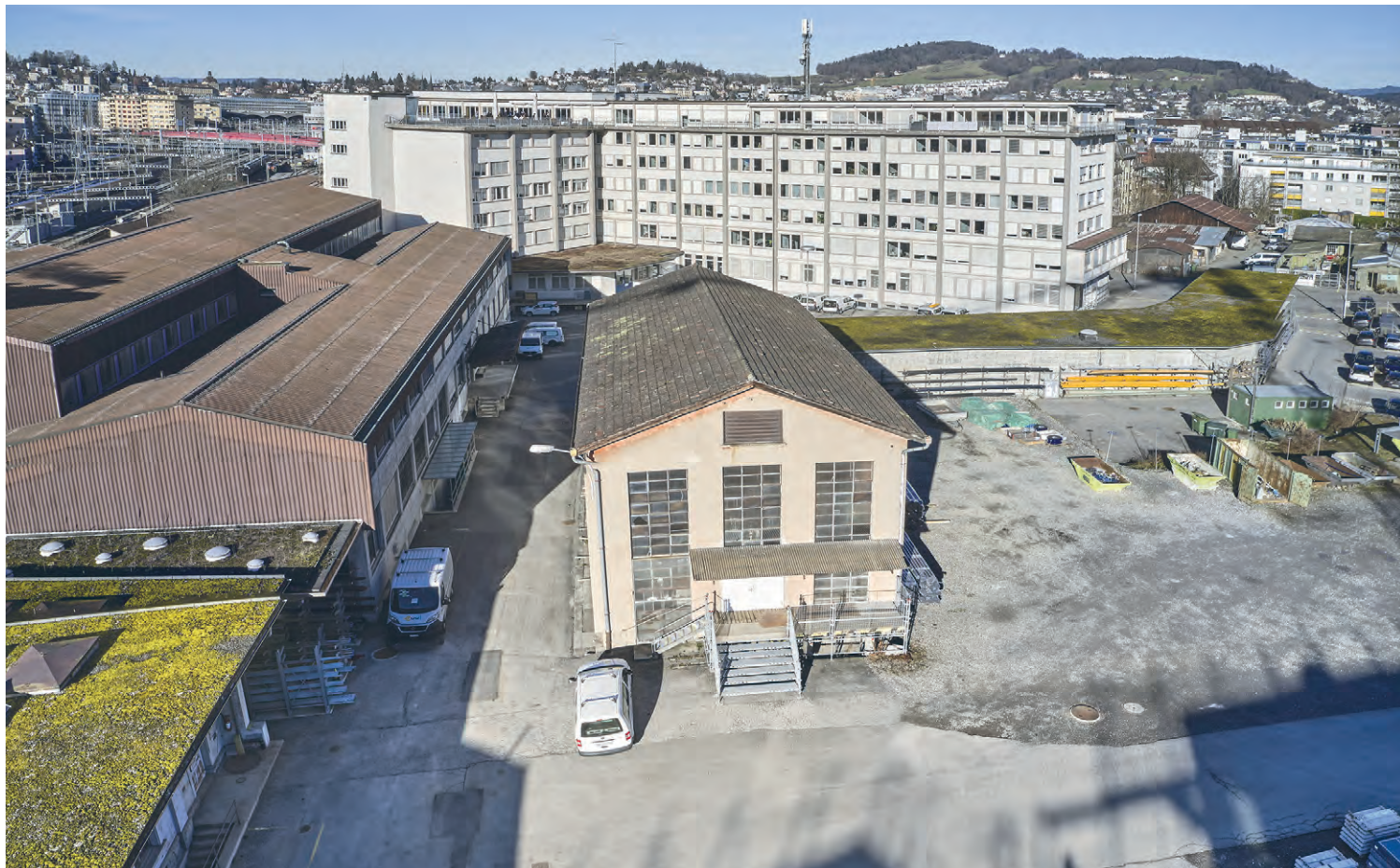
Bleibt bestehen und wird saniert: das Rote Haus. Im Hintergrund (weiss) ist das ewl-Gebäude zu sehen.
