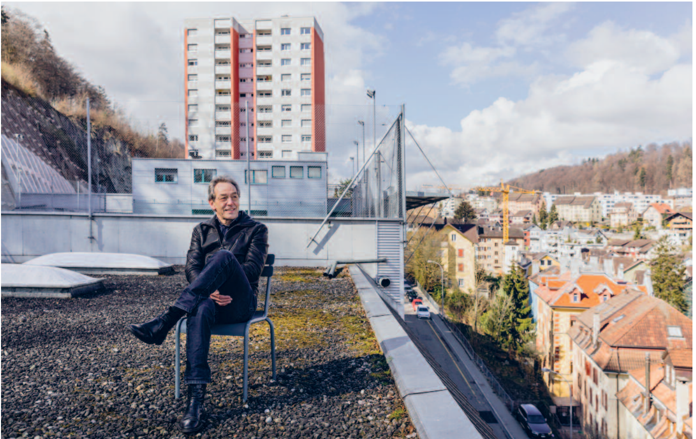
abl-Präsident Ruedi Meier auf dem Dach des ehemaligen Druckereigebäudes an der Sagenmattstrasse – hier soll zukünftig Wohnraum entstehen mit einem öffentlichen Zugang zum Gütschwald.
