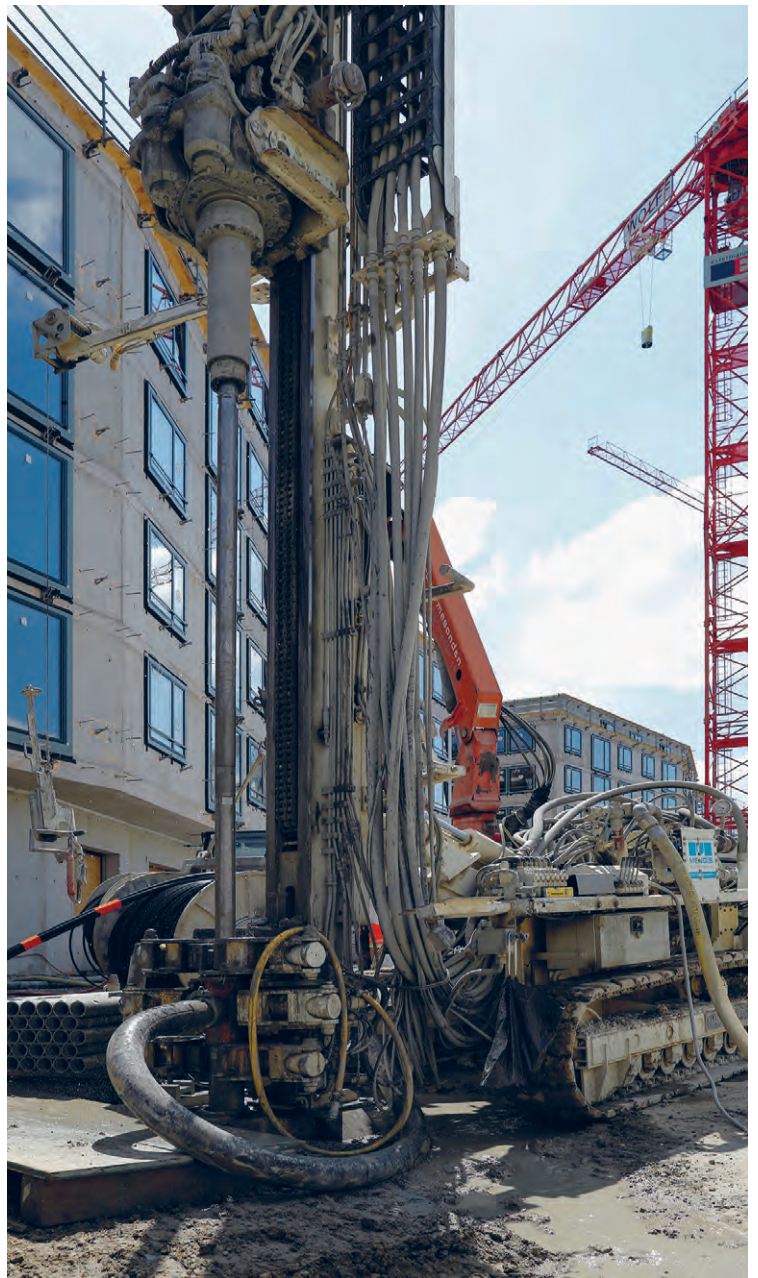
Hier gehts senkrecht in den Boden: Diese riesige Bohrmaschine stand für die Erdwärmebohrungen im Obermaihof im Einsatz.
