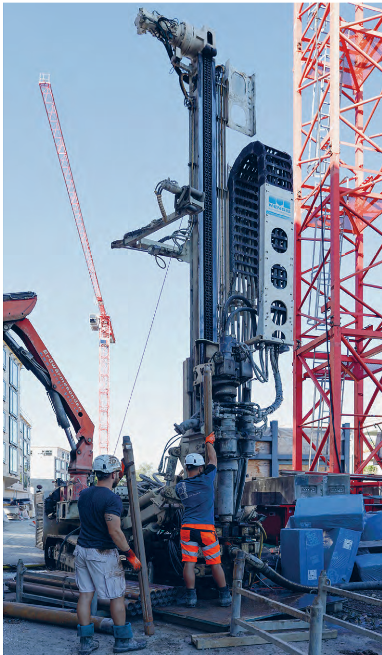
Hier gehts senkrecht in den Boden: Diese riesige Bohrmaschine stand für die Erdwärmebohrungen im Obermaihof im Einsatz.
