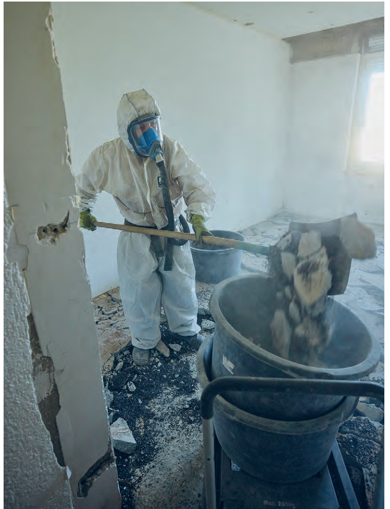
Das mit Naphthalin belastete Material wird unter Schutzbedingungen bis auf den Grund restlos entfernt.
