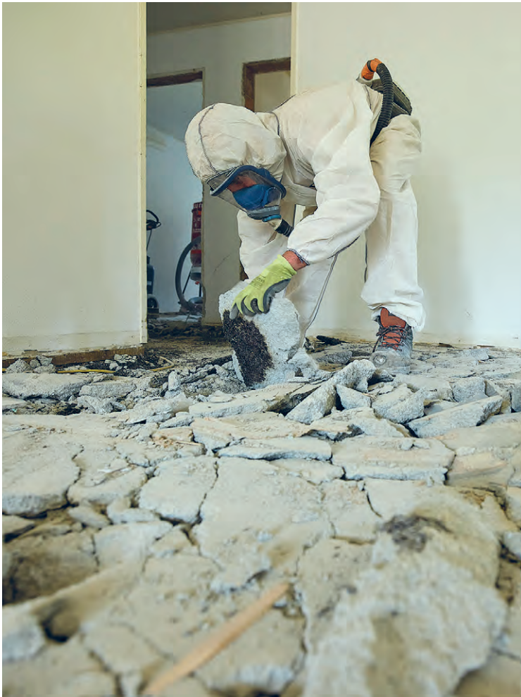
Das mit Naphthalin belastete Material wird unter Schutzbedingungen bis auf den Grund restlos entfernt.
