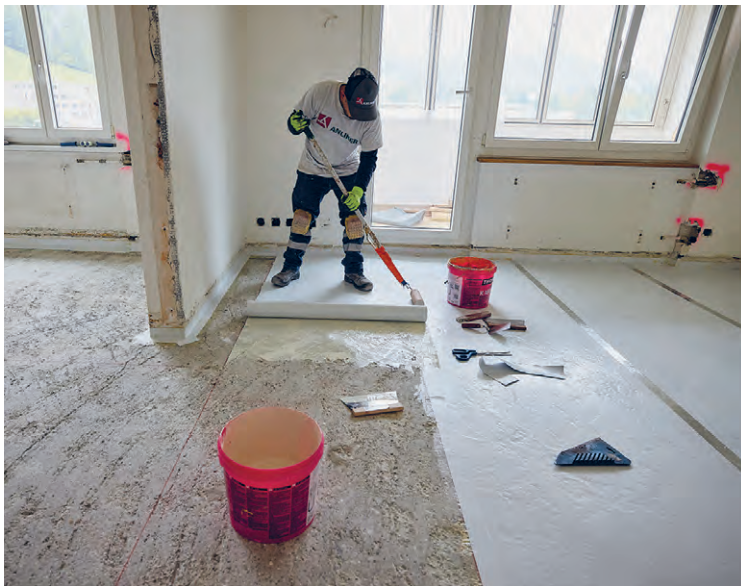
Die Böden werden mit einer Schutzfolie abgedichtet. Danach folgt der Einbau der Bodenheizung mit Dämmschicht und eines Parketts.
