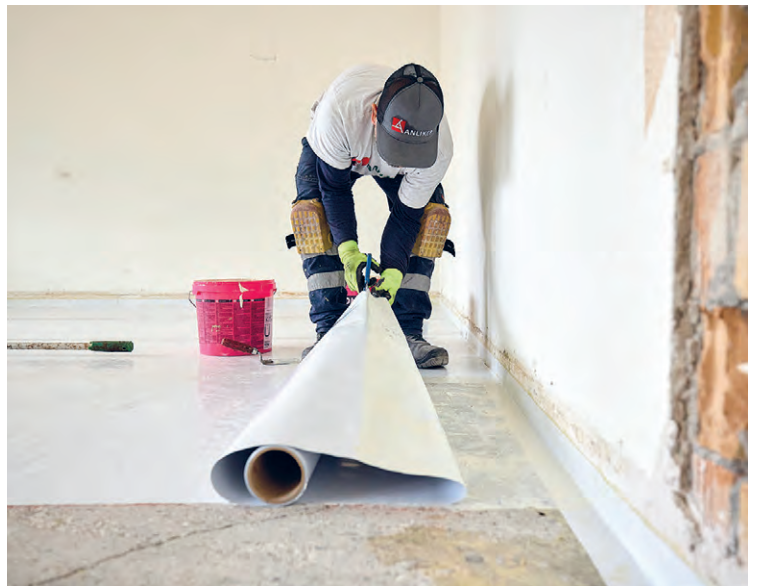
Die Böden werden mit einer Schutzfolie abgedichtet. Danach folgt der Einbau der Bodenheizung mit Dämmschicht und eines Parketts.
