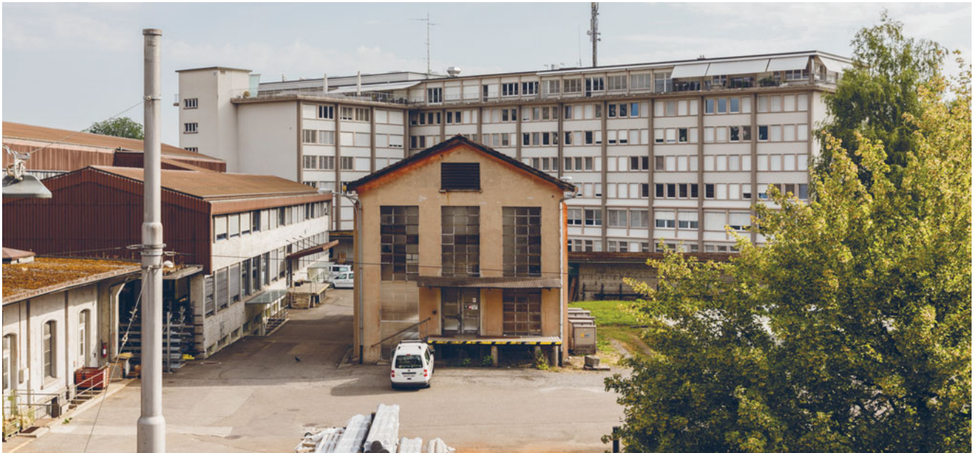
Das ewl-Areal zwischen Industriestrasse und Geissensteinring mit dem «roten Haus».
