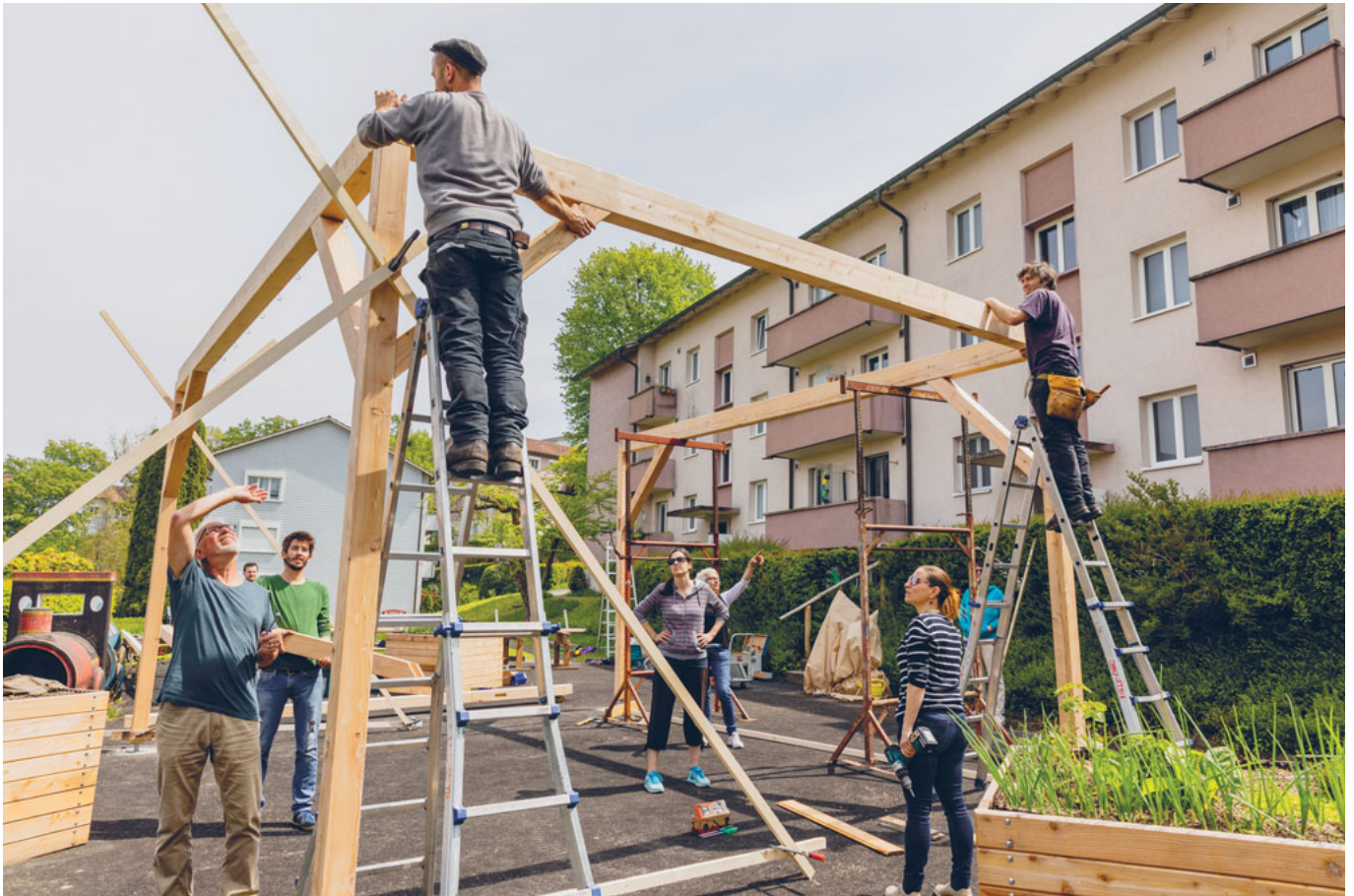
Die Pergola wurde aus massivem Schweizer Lärchenholz gebaut.
